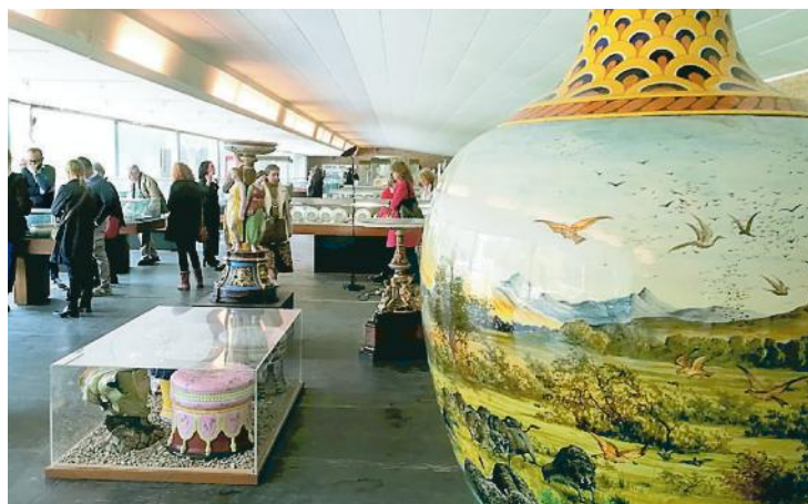
I lavori Nei prossimi giorni dovrebbe partire un intervento urgente da 1,9 milioni di euro per la ristrutturazione del tetto da cui piove acqua all'interno del museo
